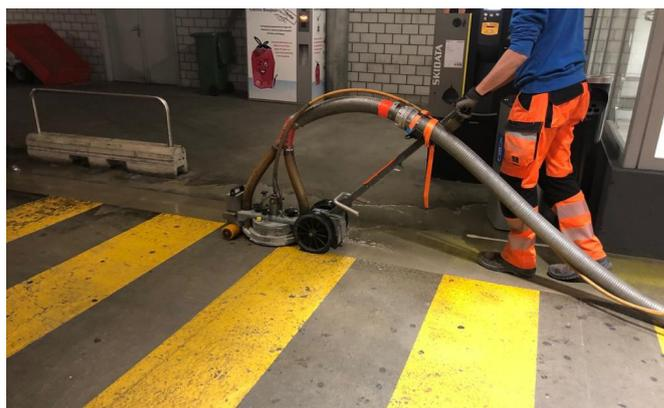
Traitement optimal des surfaces grâce à d'eau à ultra haute pression
