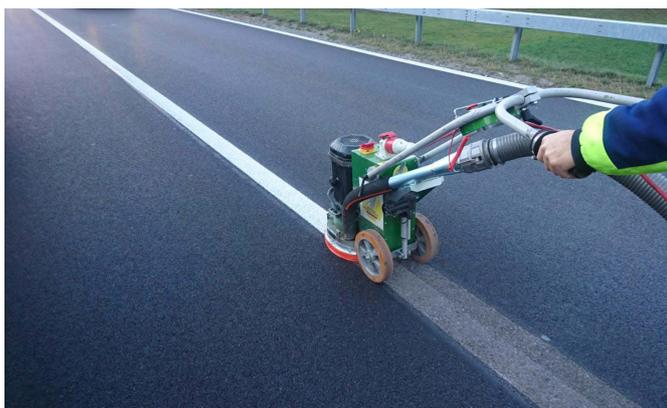
Démarquage doux des routes et des surfaces à l'aide de la technologie de ponçage horizontale de Grinding
