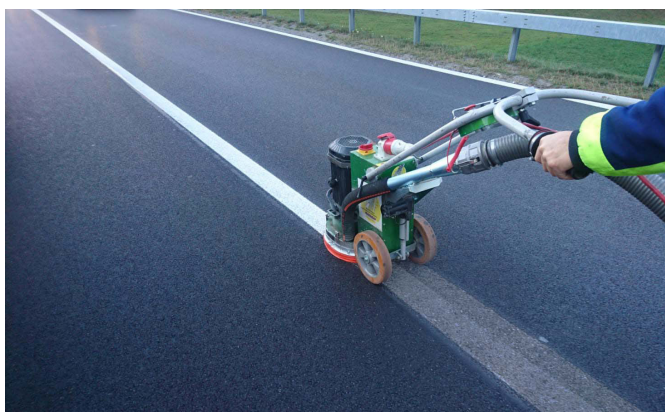
Schonende Demarkierung von Strassen und Flächen mittels Grinding Horizontalschleiftechnik
