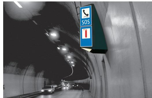
Ausgeleuchtete Signale in Tunnels werden zur Signalisierung der Sicherheitseinrichtungen eingesetzt. Es sind dies insbesondere die Lage der SOS Nischen und Feuerlöscher sowie der Fluchtweg. Durch helle und langlebige Leuchtmittel wird eine gute Erkennbarkeit nachhaltig sichergestellt.
