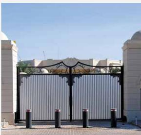
Die Antiterror-Poller sind extrem widerstandsfähig und bedingen eine besondere Verlegetiefe, um auch stärksten Einschlägen zu widerstehen. Die Antiterror-Poller basieren auf der Struktur der automatisch versenkbaren Poller. Zusätzlich ist eine fixe Ausführung erhältlich.
