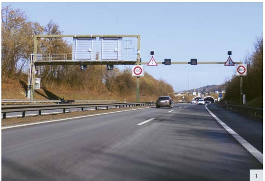
geliefert und durch einen Subunternehmer vor Ort montieren lassen. Dazu gehören auch alle LED-Fahstreifenlichtsignale sowie die LED-Gefahren- und Vorschriftssignale im Tunnel Rathausen und in den Vorzonen. Für die Montage der LED-Wechselsignale mussten spezielle Chromstahl-Befestigungen (Tunnelbereich) und Aufstellvorrichtungen konstruiert und hergestellt werden. Es wurden nur modernste Technologien eingesetzt: LED-Komponenten der neuesten Generation und R3-Folien für höchste Sichtbarkeit.
