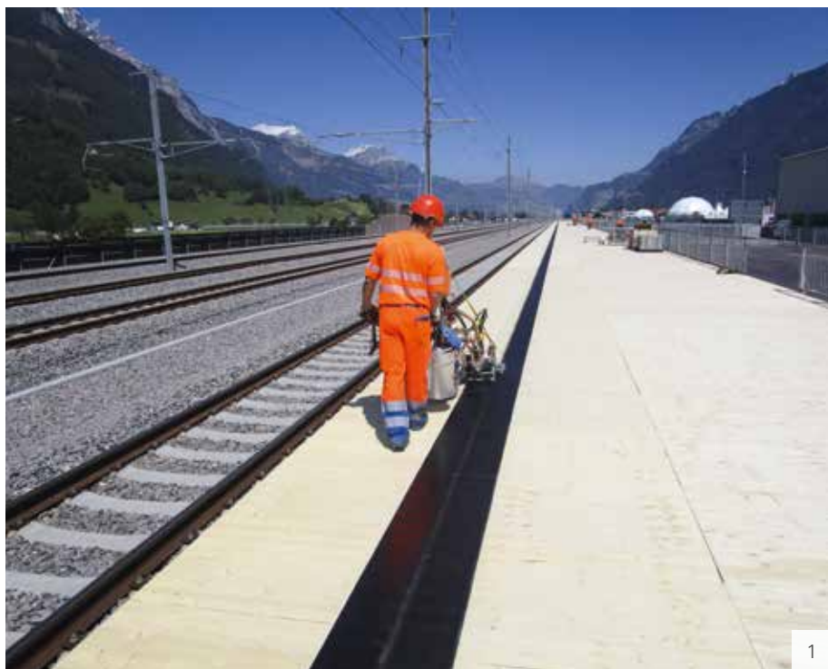
Bild 1: Ein Markierer der Segnaletica Mordasini SA appliziert den unterlegten Sicherheitsstreifen (50 cm breit).
