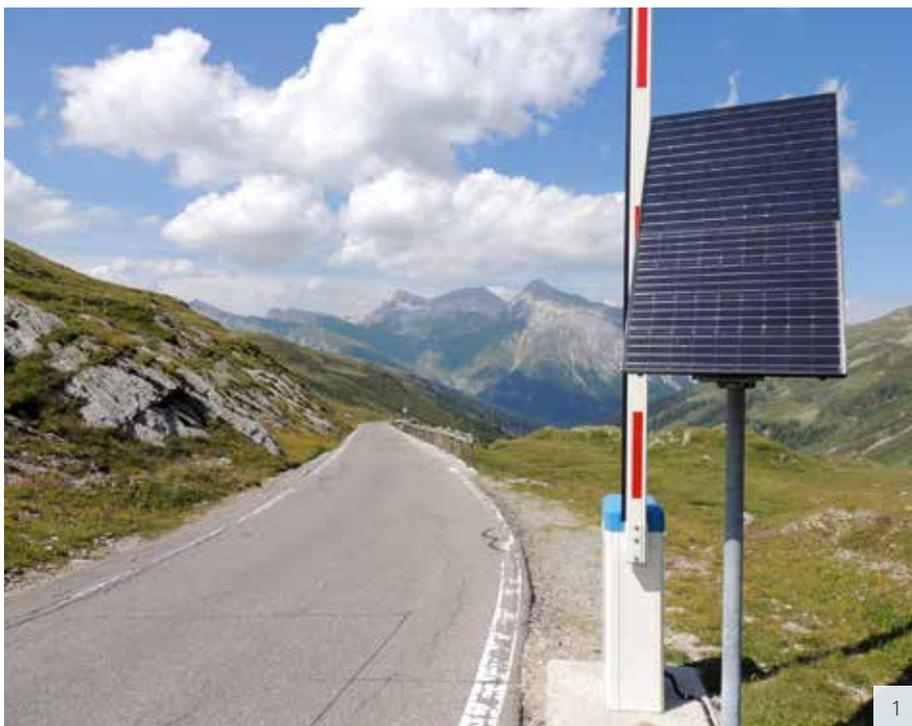
lich bewegt werden muss (durchschnittliche Anzahl der Schneetage während des Passbetriebs), war eine solarbetriebene Schranke die optimale Lösung. An der Suisse Public im Juni 2015 wurde das Tiefbauamt auf die Solar-Elektro-Schranke aufmerksam. Ein knappes Jahr später war die Schranke installiert – auf 2115 Meter über dem Meer.
