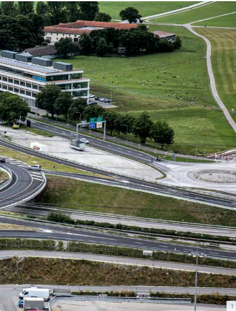
Bild 1: Blick von oben auf den neuen Grosskreisel Chur Süd.
