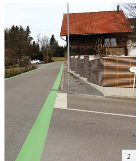
Bild 1+2: Optische Einengung der Fahrbahn mit 350 Meter Strassenmarkierung
