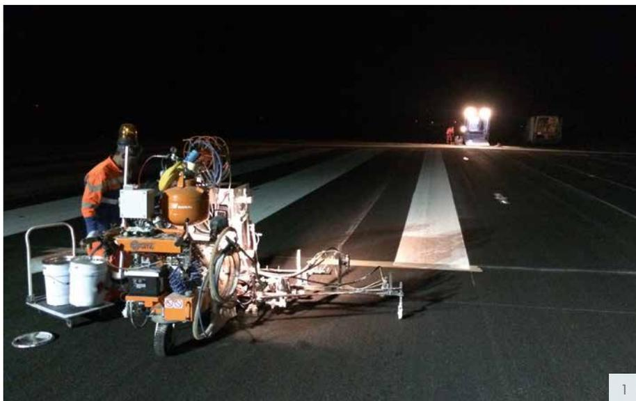
Image 1: La machine de marquage Airless en pleine action la nuit. Spécialement adaptée pour le projet, elle a une largeur de ligne de 90 cm
