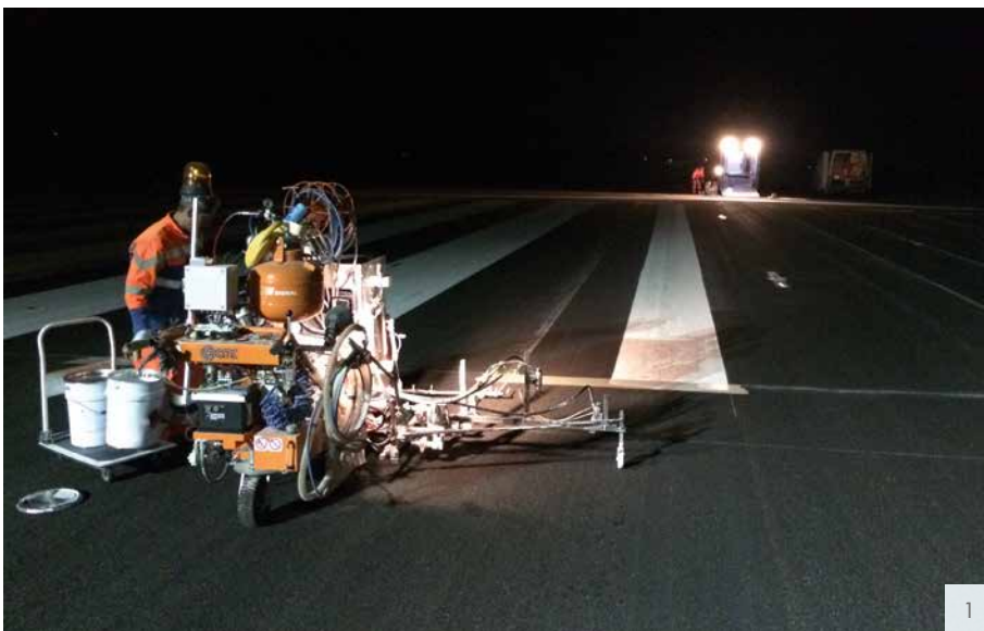
Bild 1: Am Anfang der Landebahn werden die Querbalken (Threshold) mit der speziell umgebauten Airless-Maschine markiert
