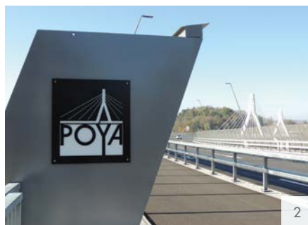
Images 1/2: Pont de la Poya, Fribourg
