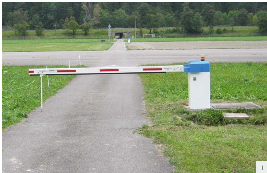
Image 1: La barrière commandée par radio depuis l'avion réduit le risque d'accident.
