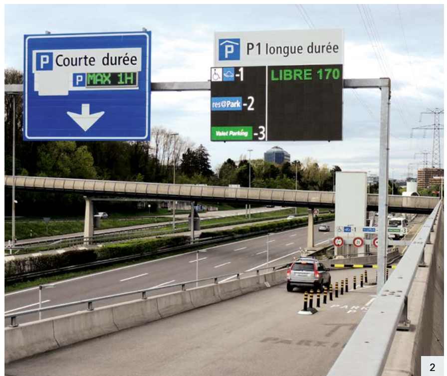
Bild 1+2: Die neue Full-Graphic-LED-Anzeige am Flughafen Genf zeigt in Echtzeit die Anzahl verfügbarer Parkplätze an.
