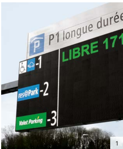
Bild 1+2: Die neue Full-Graphic-LED-Anzeige am Flughafen Genf zeigt in Echtzeit die Anzahl verfügbarer Parkplätze an.
