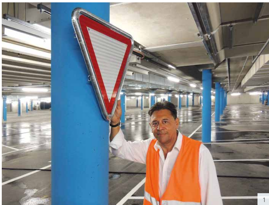
Bild 1: Fachberater Robert Wissmann vor einem direkt auf die Betonsäule montierten „Kein Vortritt“-Signal 3.02 R2.
