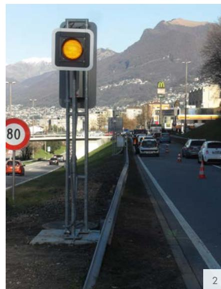
Bild 2: Stufe 2 – Ein Blinker Richtung der Verkehrsteilnehmer und die Ampel Richtung potenzieller Falschfahrer
