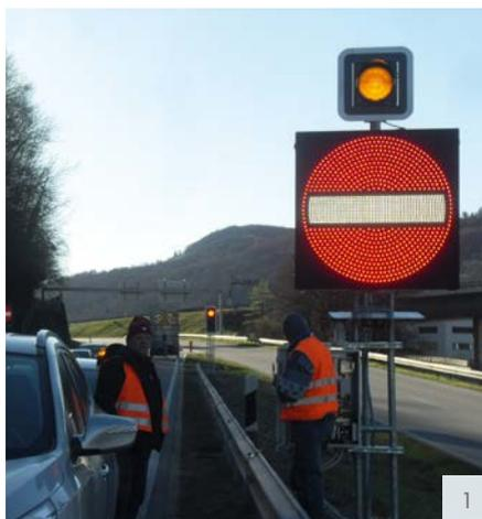
Bild 1: Stufe 1 – Installation und Tests der sensorgesteuerten LED-Anzeige mit Blinker
