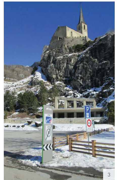
Bild 3: Eingang Begegnungszone und Kirche
