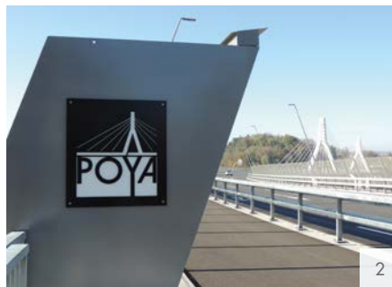
Bild 1/2: Poya Brücke Freiburg
