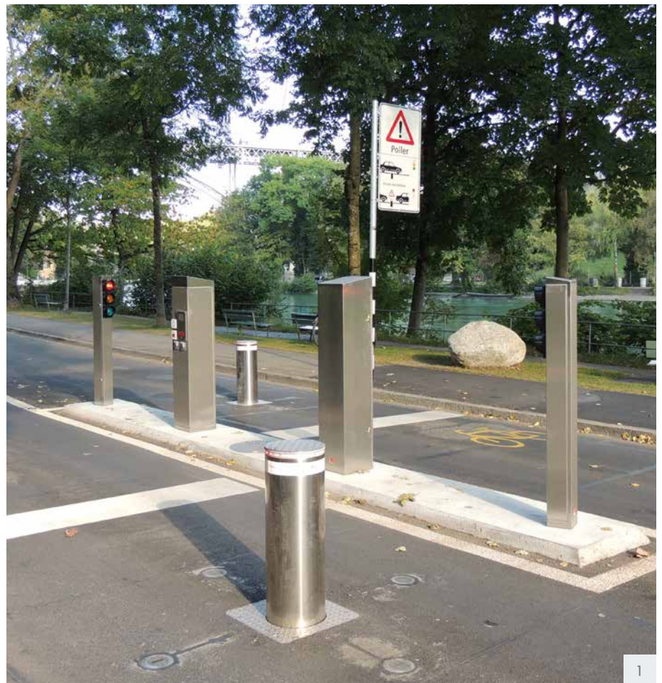
Bild 1: Die neue Polleranlage im Berner Mattequartier fixfertig installiert
