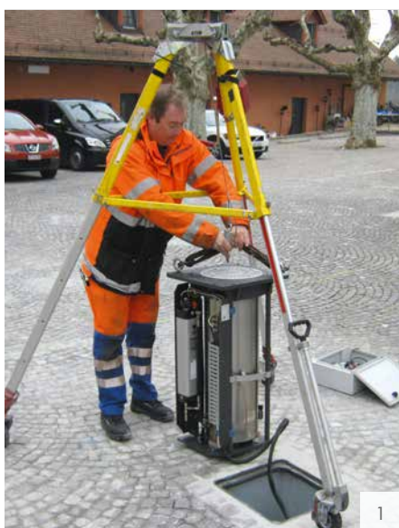
Image 1: Maintenance d'une installation de borne
