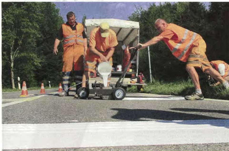
Die Rüttelstreifen werden als zähflüssige Masse auf die Strasse appliziert.
