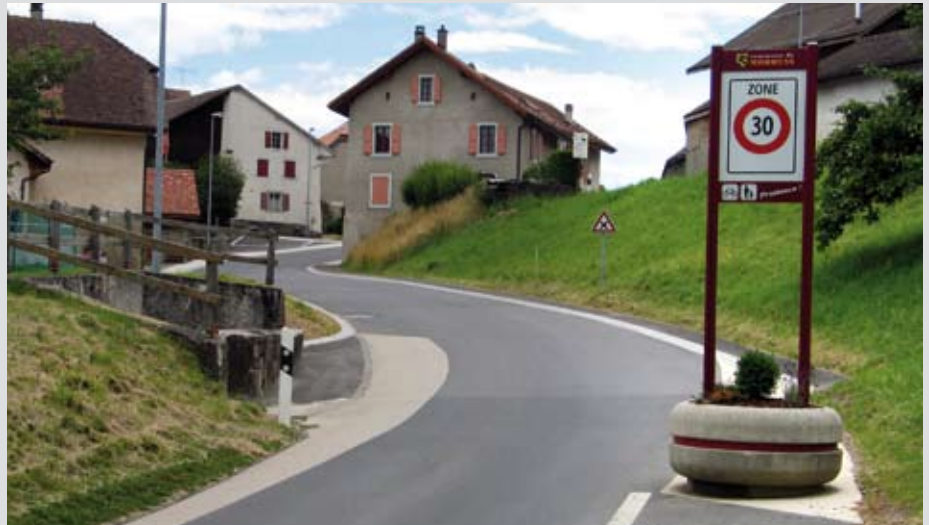
Torsituation bei der Ortseinfahrt durch Stelen mit Pflanztrog und Markierung
