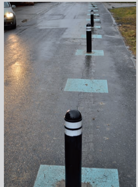
...mittels Markierung und Pfosten
