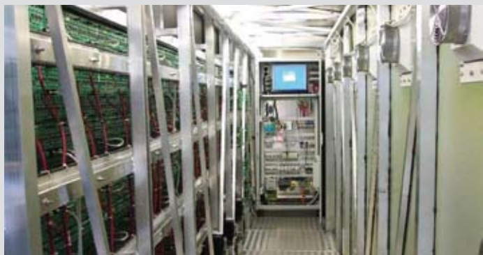
Die Signalgehäuse sind begehbar ausgeführt (Quelle: AWK)
