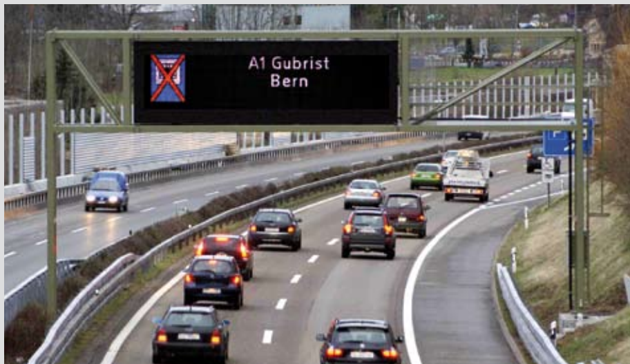
Informationen über regionale und überregionale Ereignisse auf dem Strassennetz (Quelle: AWK Group AG)
