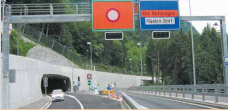
Offene und geschlossene Prismensignale bei Tunneleinfahrt und Zufahrtsstrassen
