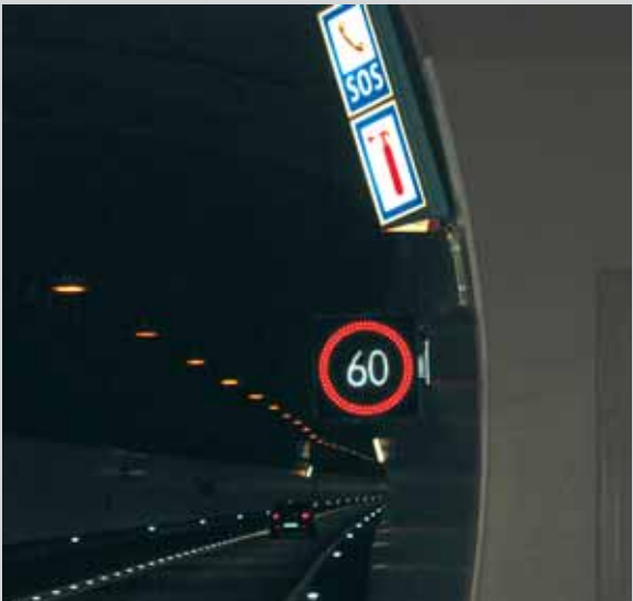
Blendfreie Leuchtsignale im Tunnel
