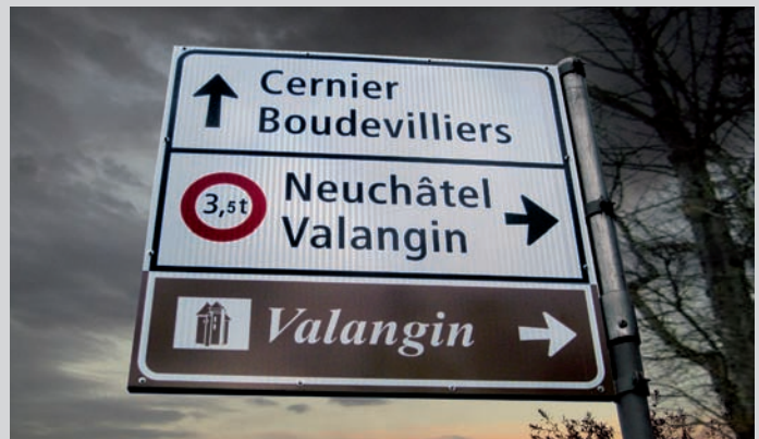
Signaltafel nach der Sanierung mit Folie der Klasse R2
