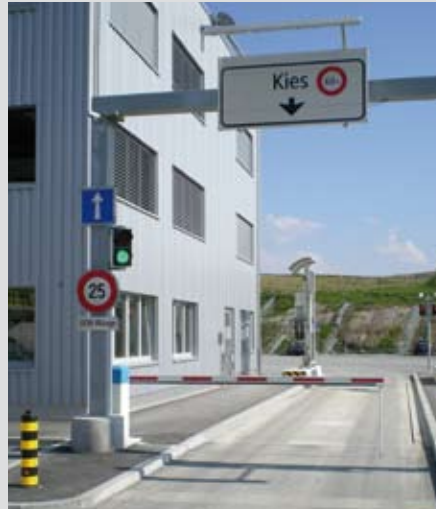
Zutrittskontrolle zur LKW-Waage
