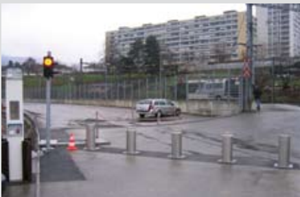
Locarno: Fahrspur mit automatischer Polleranlage für autorisierte Fahrzeuglenker
