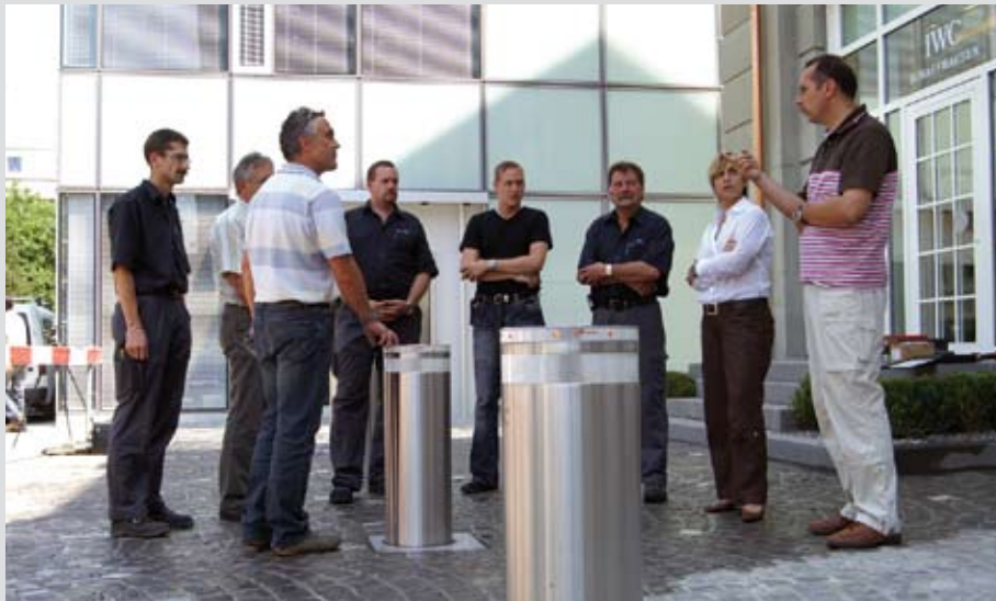
Inbetriebnahme und Instruktion der Anlage
