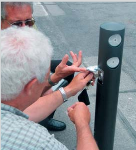
Statischer Poller mit Schlüsselschalter, herausnehmbar
