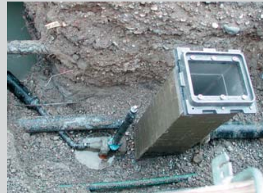
Wasserdichte Pollerverschaltung mit Entwässerung
