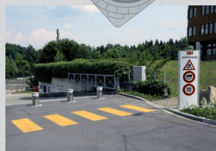
Einfahrt zur Tiefgarage/Anlieferung
