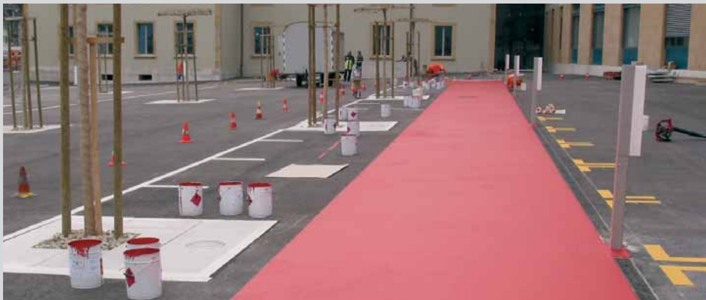
Der Parkplatz wird markiert; der 2-Komponenten Kalkplastik ist mit Anti-Rutsch-Komponenten versehen
