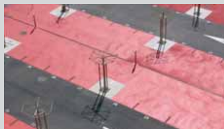
Vollflächig markierte Parkflächen
