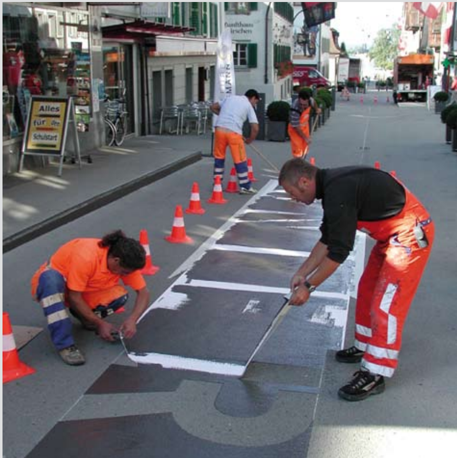
Auftraggeber für die Markierungsarbeiten: Bezirk Küssnacht, Herr André Guntern
