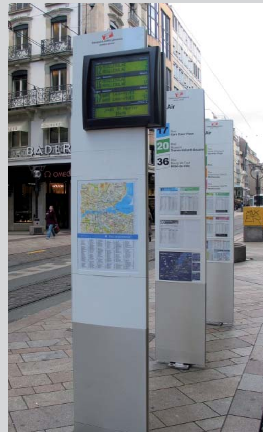
Stele mit integrierter elektronischer Abfahrtsanzeige
