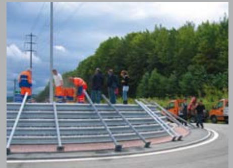
Bereitstellung der Rohrmaschinen
