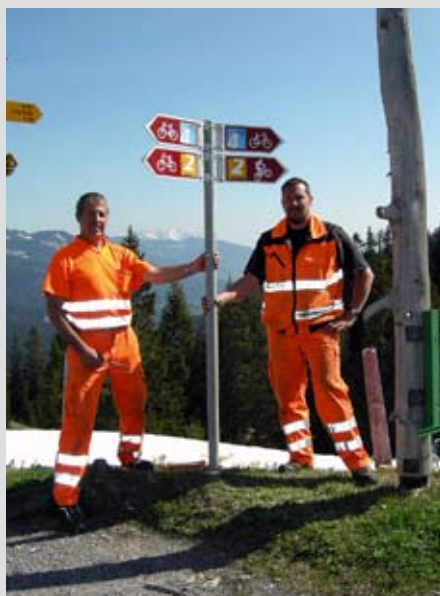
Montage-Equipe im Einsatz
