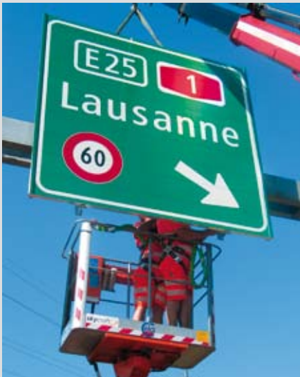
Montage der neuen Grossflächentafel durch die Equipe der SIGNAL AG
