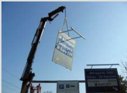
Demontage der alten Signalisation
