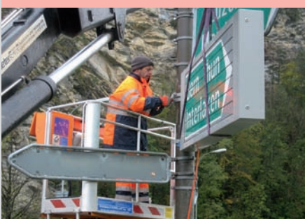
Montage der Grossflächentafeln
