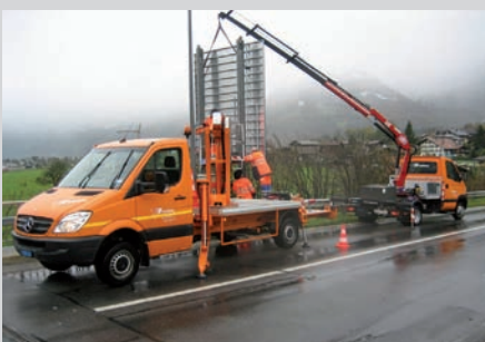
Montage der Grossflächentafeln
