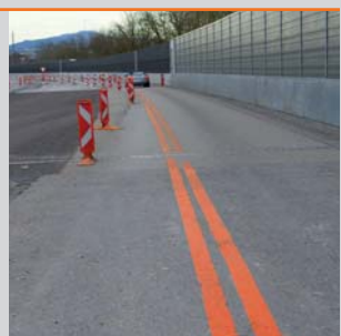
Temporäre Markierungen in Baustellen sowie Demarkieren von alten Markierungen
