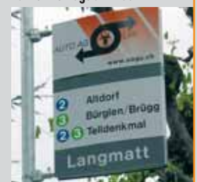
Fahnenmontage am Mast
